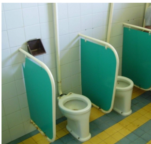
Dětské WC před rekonstrukcí
