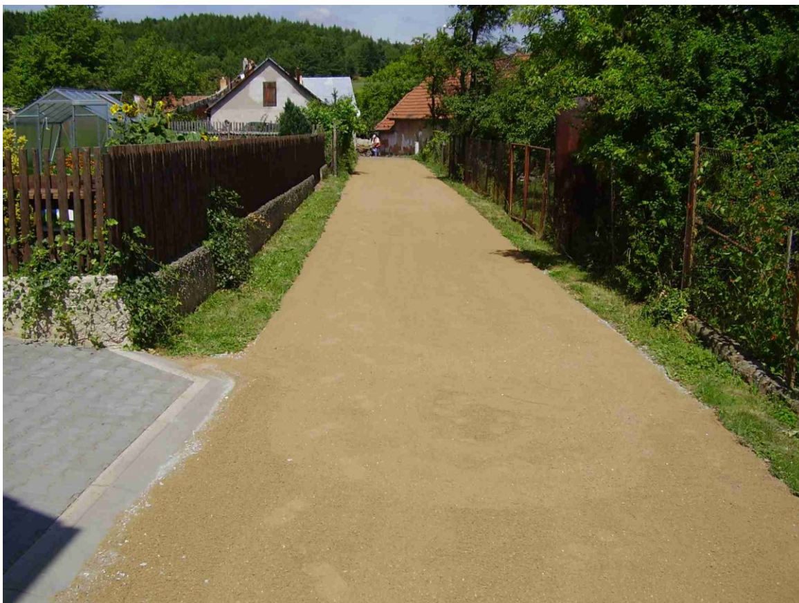
Vodopropustná komunikace ke Köhlerovým foto: Ing. Zdeněk Toul
