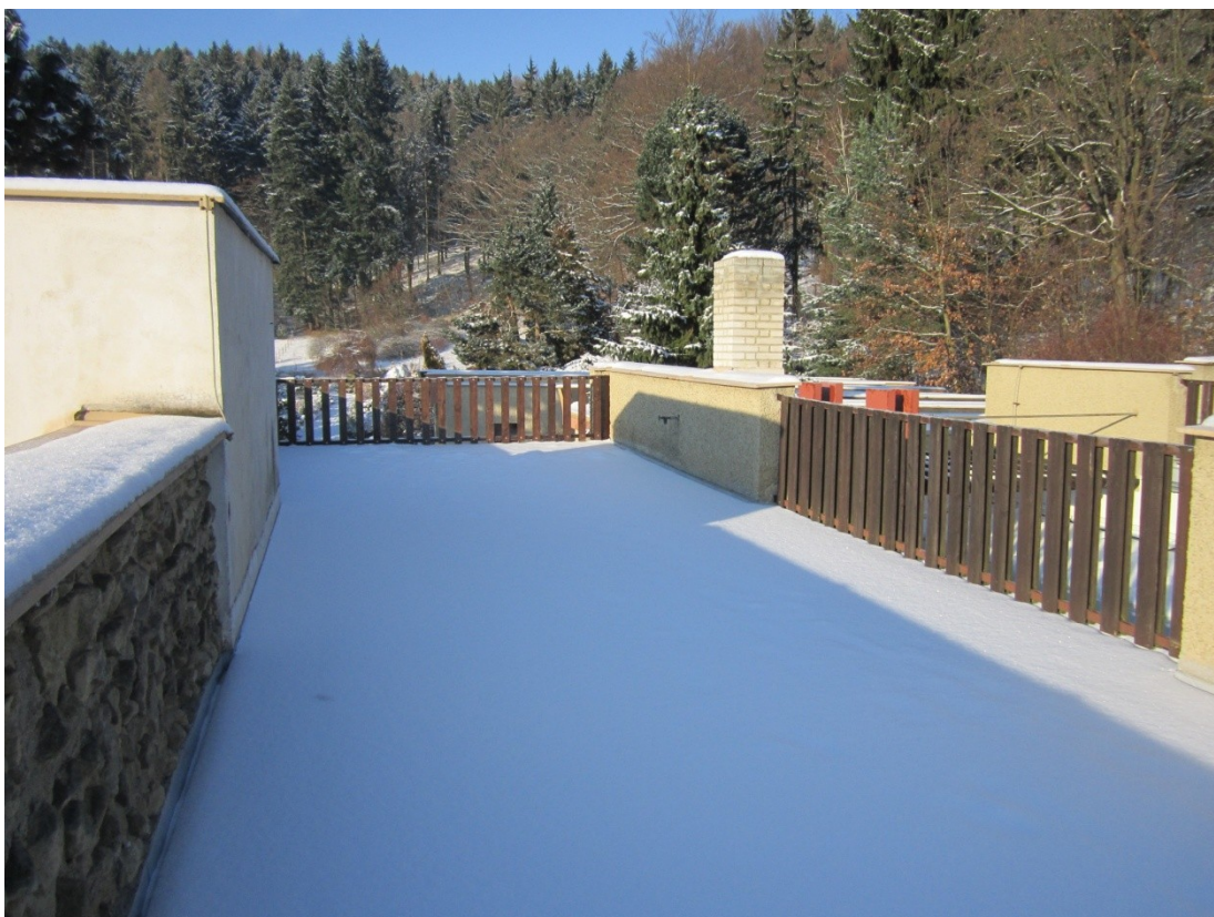
Opravená terasa na výstavním pavilonu v arboretu v Borotíně
