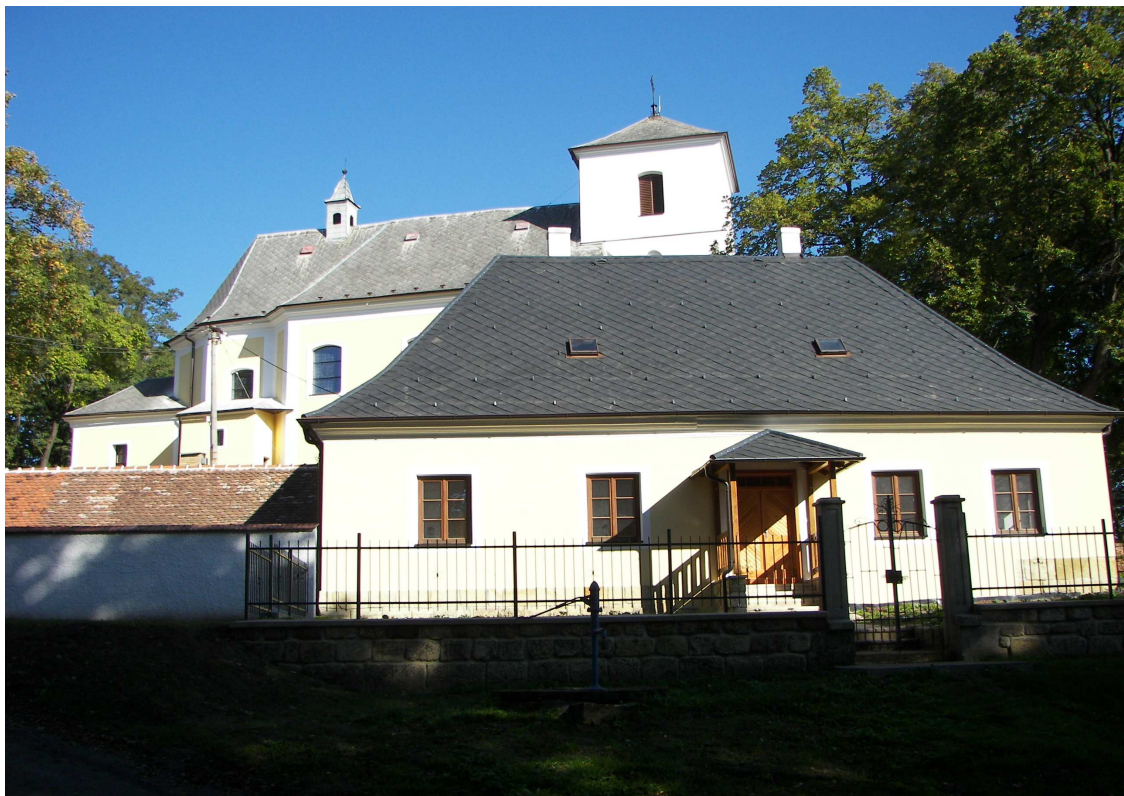
Kostel Povýšení sv. Kříže a borotínská fara po opravě
