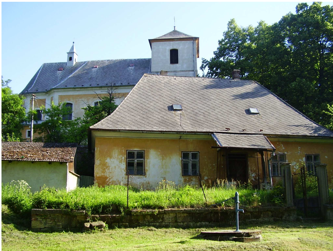
Pohled na kostel a faru před rekonstrukcí
