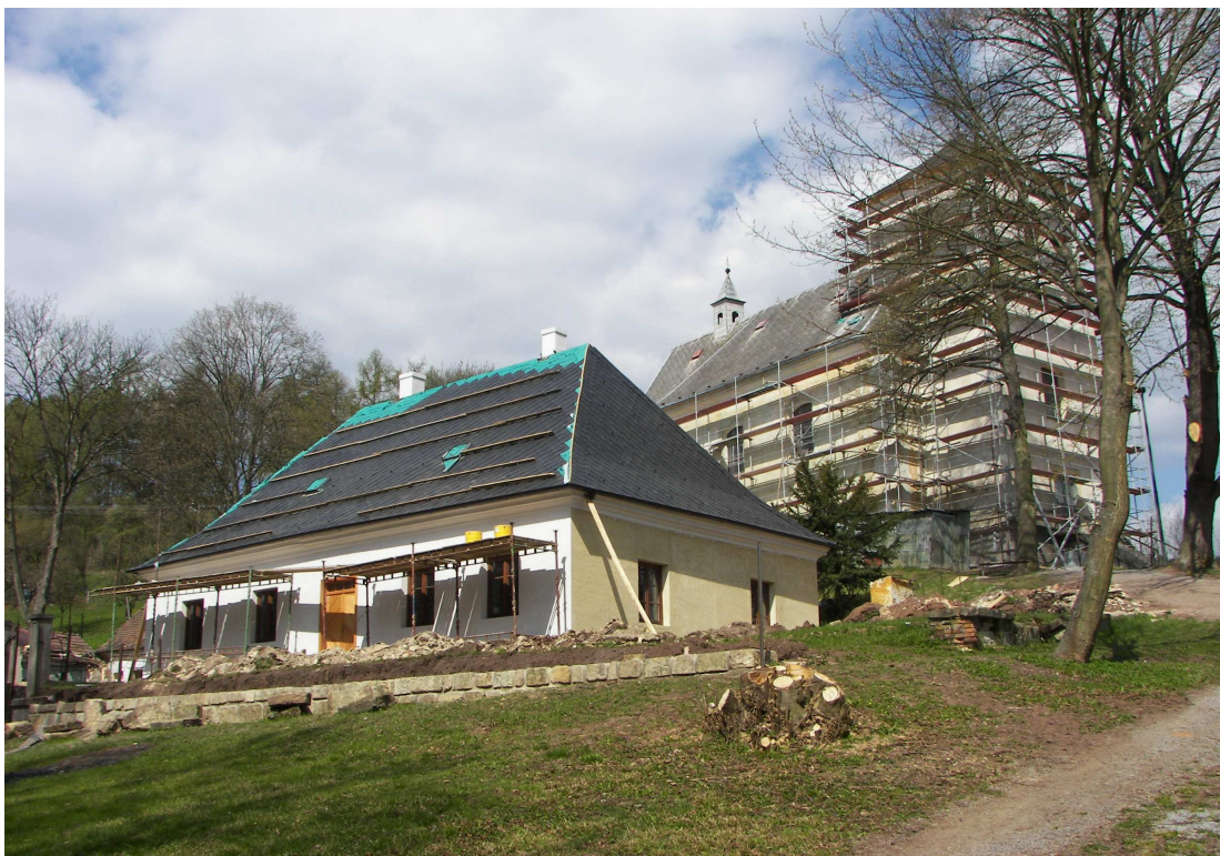
Oprava fary a kostela v Borotíně
